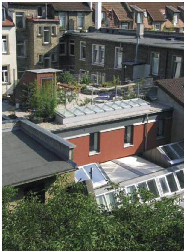
Um die niedrigen, kleinen Räume des ehemaligen Holzlagers einer Schreinerei als Wohnraum nutzen zu können, musste der gesamte Dachstuhl angehoben werden. Fast alle Zwischenwände konnten entfernt werden. Heute steht ein großer Wohn- und Lebensraum zur Verfügung, der lediglich durch zwei tragende Stützen unterbrochen wird. Die 2,70 Meter hohen Räume, verfügen über große seitliche Fensterflächen. Über die neu eingebauten Oberlichter bekommen die Räume zusätzliches Licht.
